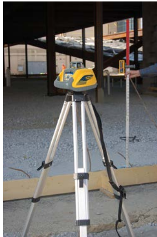
Außenanwendung-Einmessen von Schalungen
